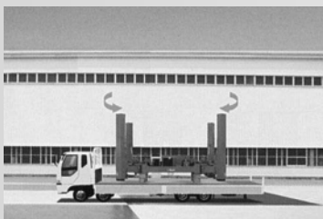
③ジャッキを横へ廻す。
