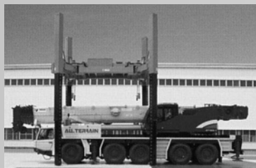
⑥ジャッキをオールテレーンクレーンの所定位置まで下げて、リフターとブームを接続する。
